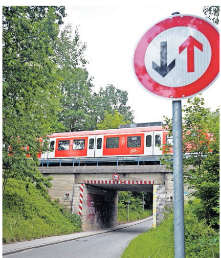
Die Bahnüberführung an der Station Wächterhof ist wegen Instandhaltungsarbeiten derzeit gesperrt. FOTO: SCHUNK
