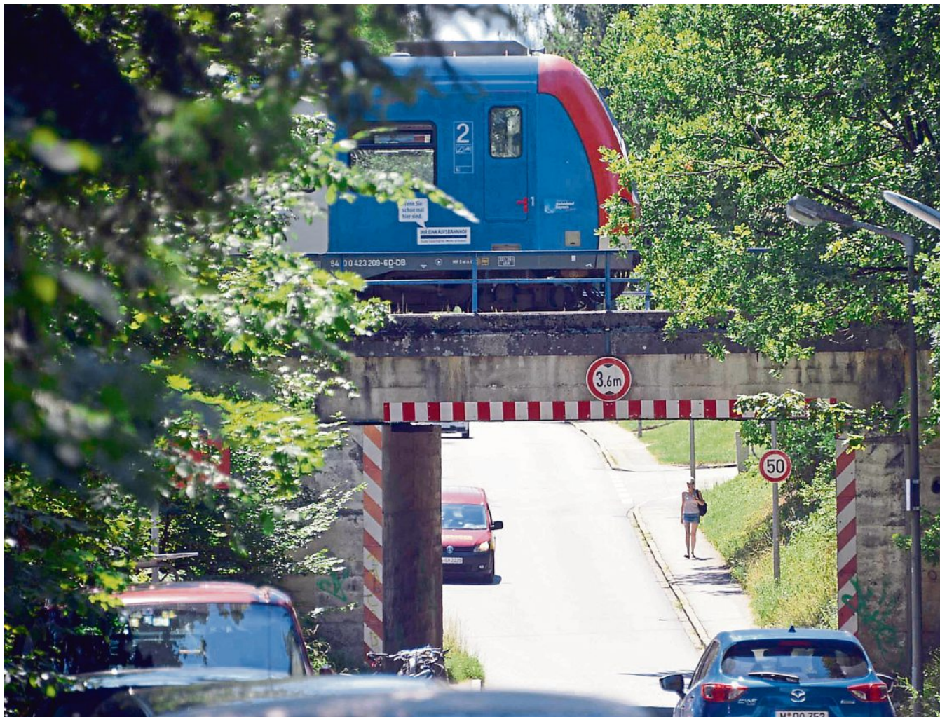
Ein Ausbau der S-Bahnunterführung – ist eine der Varianten, die zur Diskussion stehen.
